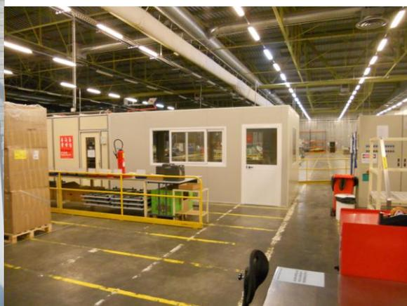
PANNEAU SANDWICH A MONTAGE HORIZONTAL, JONT INVISIBLE et SANS PONT THERMIQUE
